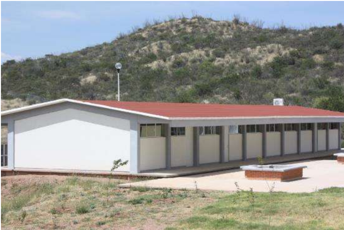
Edificio de laboratorios de: Química, Industrial y Cisco
